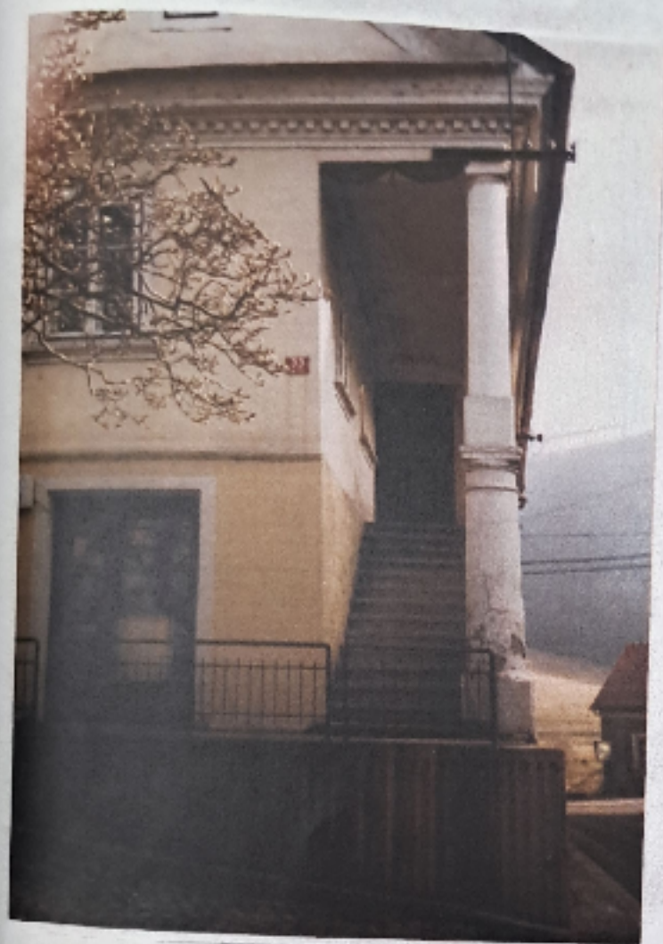
STOPNISČE KOLENČEVE HIŠE
