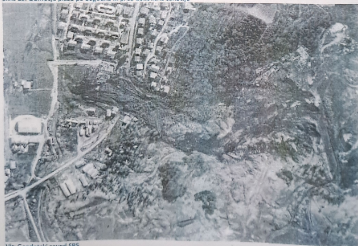
Slika 18: Območje plazu po dogodku in pred dokončno sanacijo
